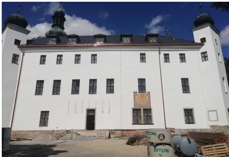
Zámecký hotel Třešť v průběhu rekonstrukce
