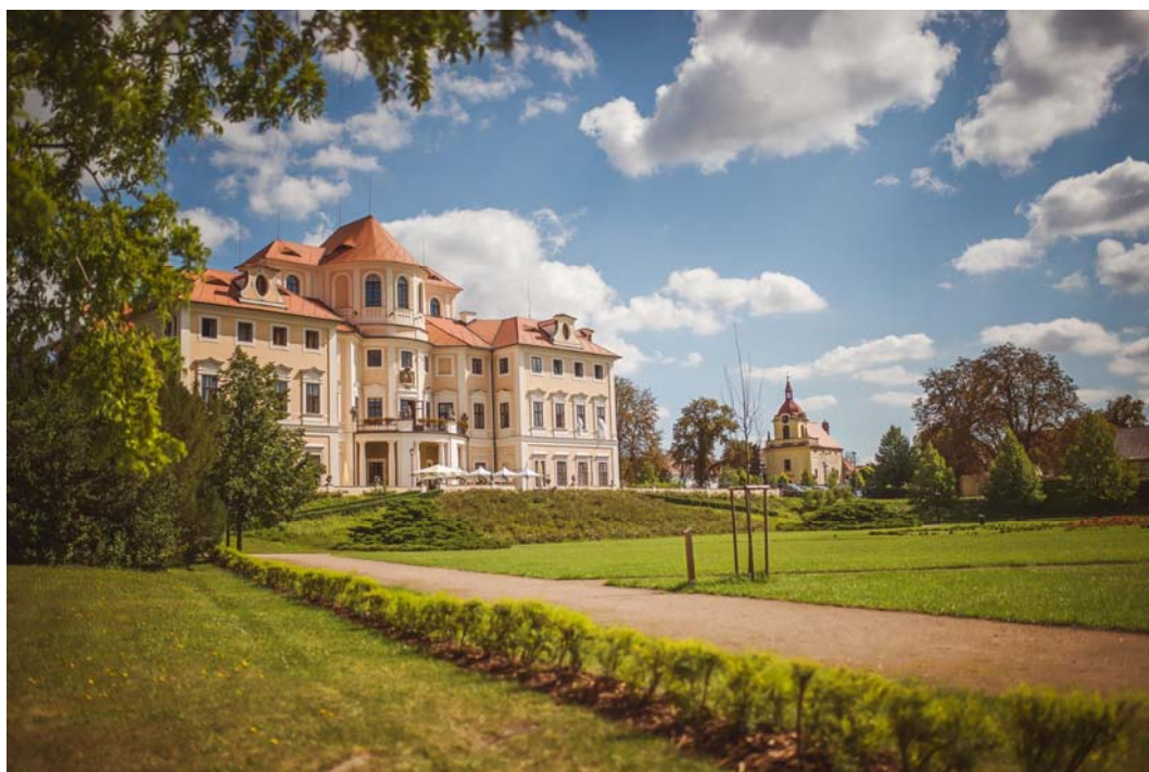
Opravené cesty v zámeckém parku
