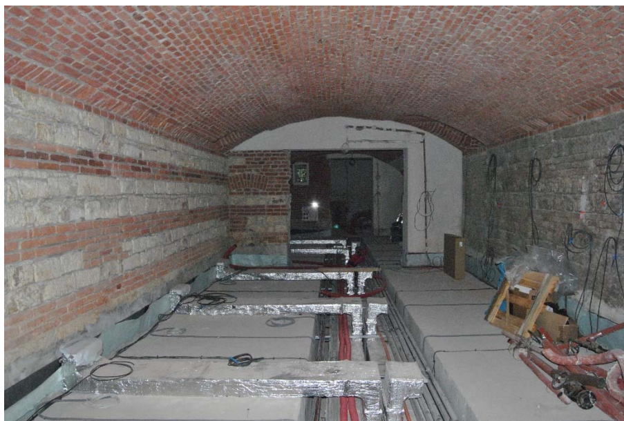
Oprava jednacího sálu VL
